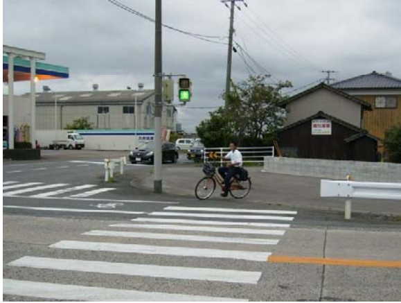
交差点隅切り部 (改良済箇所)
