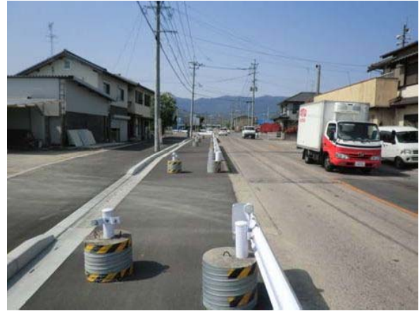
終点側から交差点を望む (歩道暫定供用部分)
