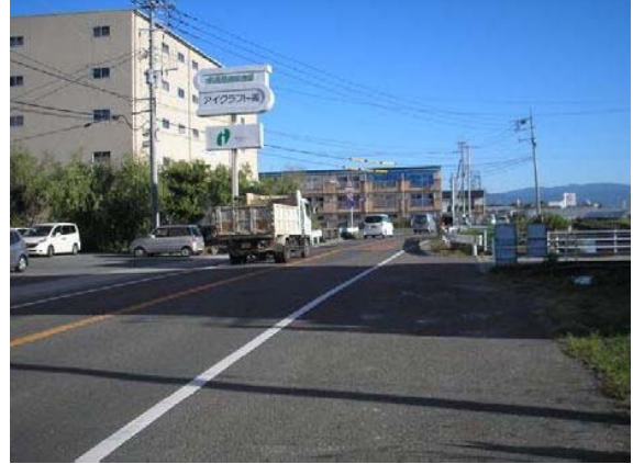
中間から終点側を望む (未改良区間)
