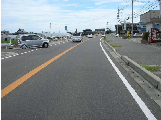
中間から起点側を望む (改良済区間)
