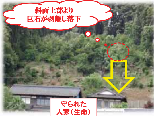
対策工実施箇所（全景）
