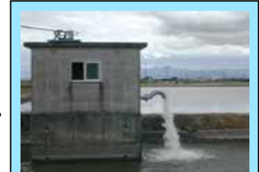
地下水くみ上げ
