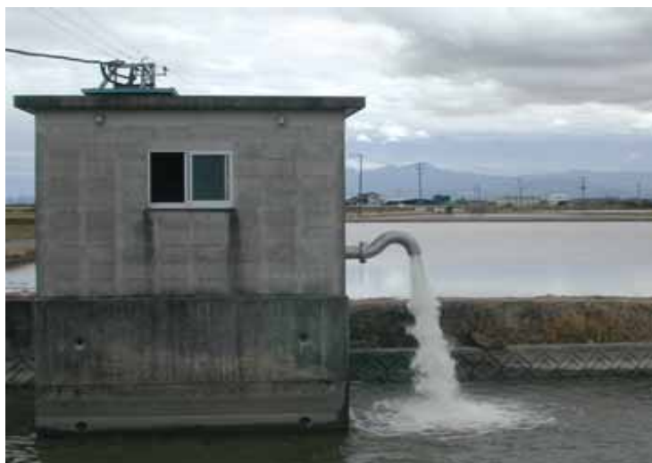
地下水の汲み上げ状況
