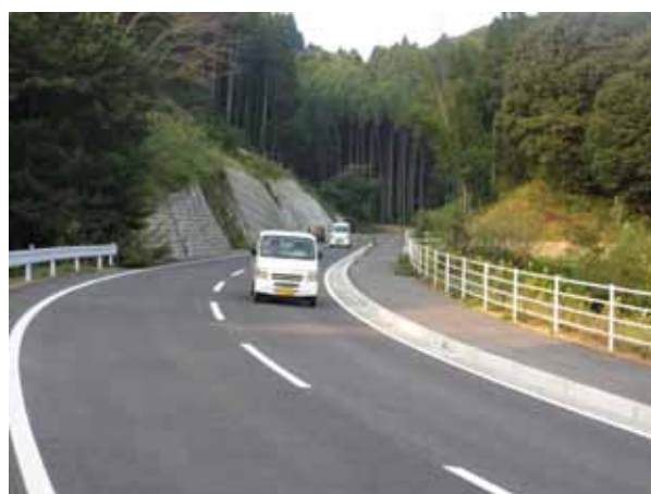
起点側から終点側を望む (改良済み区間)
