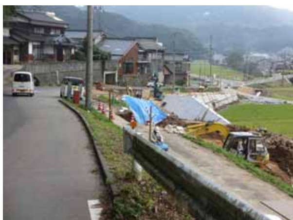
終点側から起点側を望む (改良中区間)
