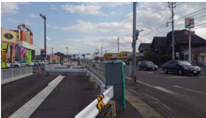
起点側から終点側を望む (拡幅部施工済み区間)
