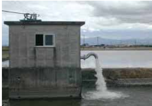
地下水の汲み上げ状況
