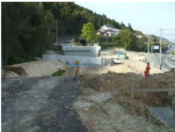
起点側から終点側を望む (起点側の整備状況)
