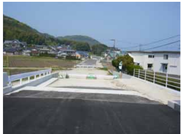
起点側から終点側を望む (終点側の整備状況)
