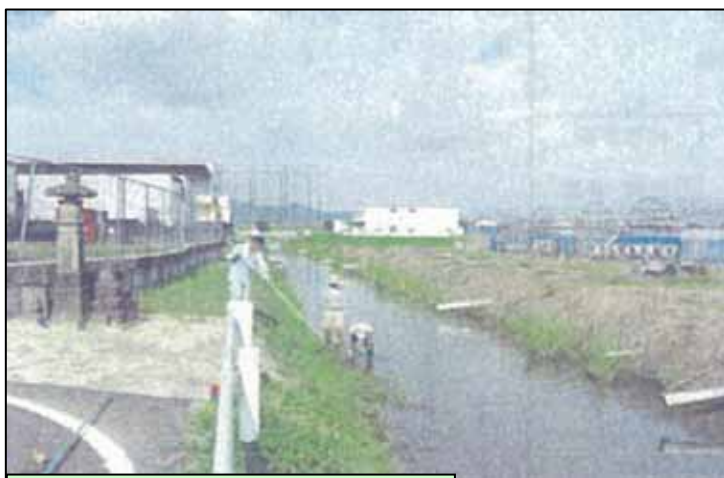
【法面の草刈り】
