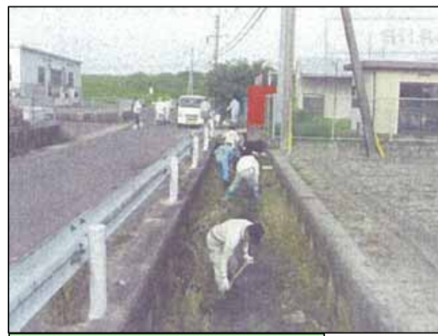
【水路の泥あげ】
