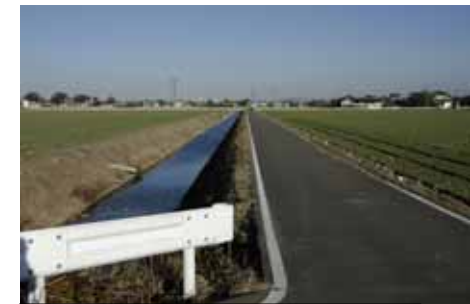
整備された農道と排水路
