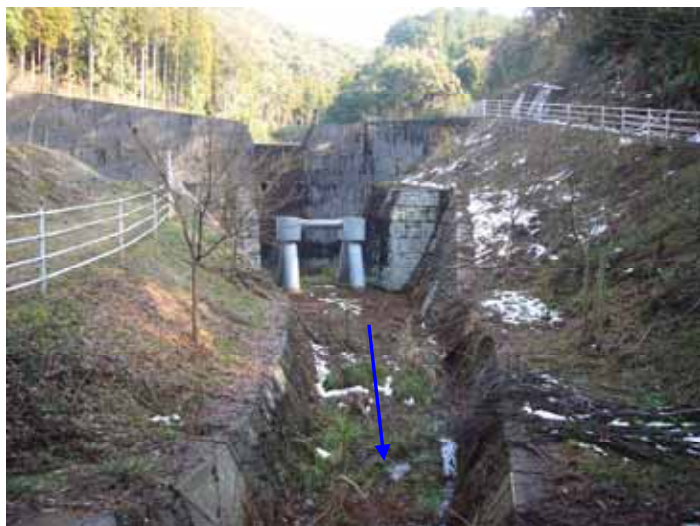
えん堤工正面
