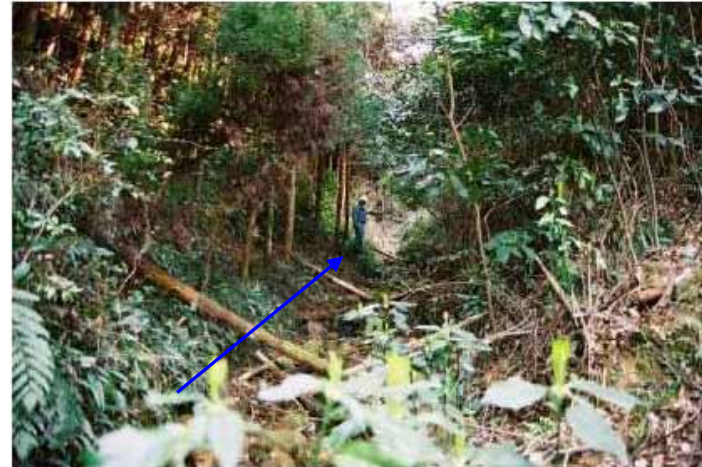
上流荒廃状況
