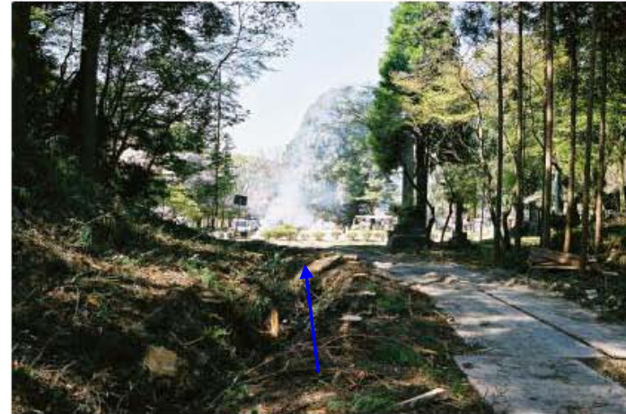
着手前 えん堤下流
