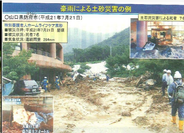
山口県防府市土石流災害 平成21年7月21日
