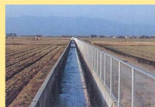
用水路の改修
