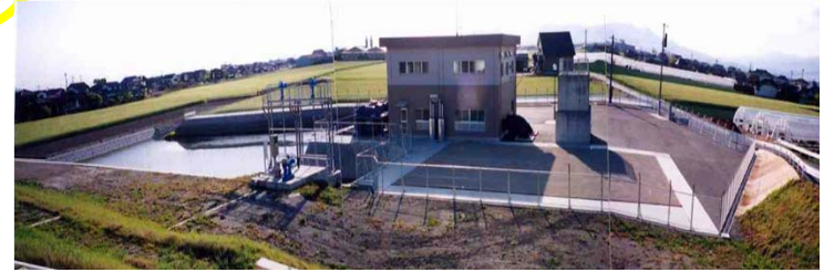
福富排水機場の整備
