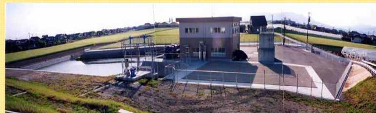
排水機場の整備
