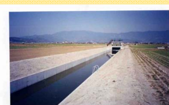
排水路の改修
