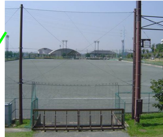
多目的グラウンド(北から)
