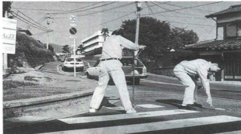
8月25日～26日 上水道12時間断水開始。市職員が配水管のバルブの開閉作業を行ないました。
