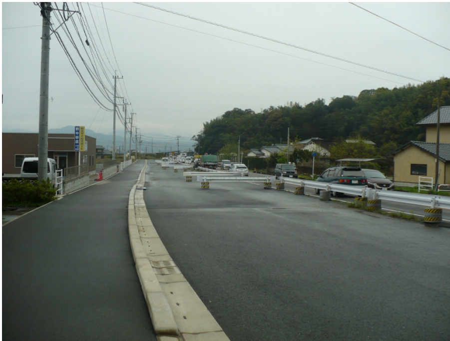
起点から終点側を望む
