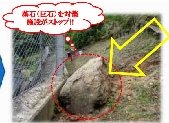
○落石を待受け擁壁が捕捉した事例
