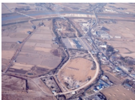
改修後の嘉瀬川（写真上部）と森林公園（昭和48年撮影）
