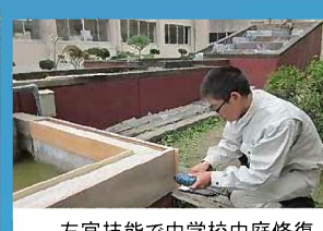
左官技能で中学校中庭修復 (土木)
