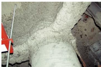
柱や梁に施工 吹付け石綿
