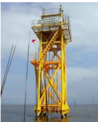
海況自動観測塔
