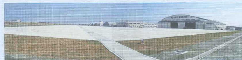
駐機場・格納庫（北徳島駐屯地）
