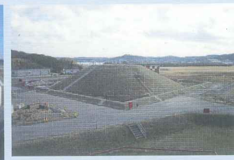
燃料タンク（館山航空基地）
