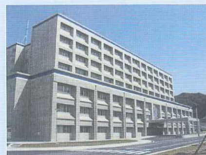
隊庁舎（高知駐屯地）
