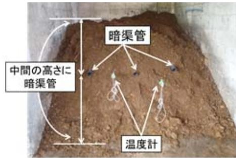
写真2 暗渠管の埋設状況
