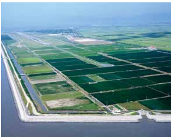
補強された海岸堤防
