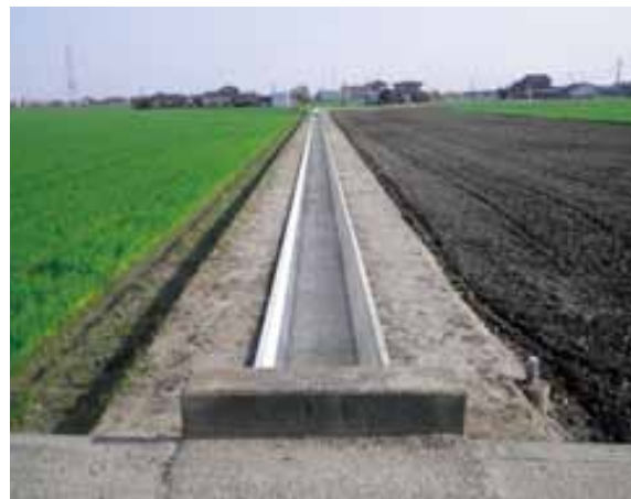
用水路の機能が復旧
