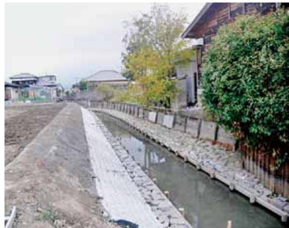
水の流れが良くなった集落内水路
