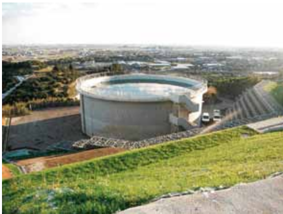
佐賀西部高域揚水機場 (吐水槽)
