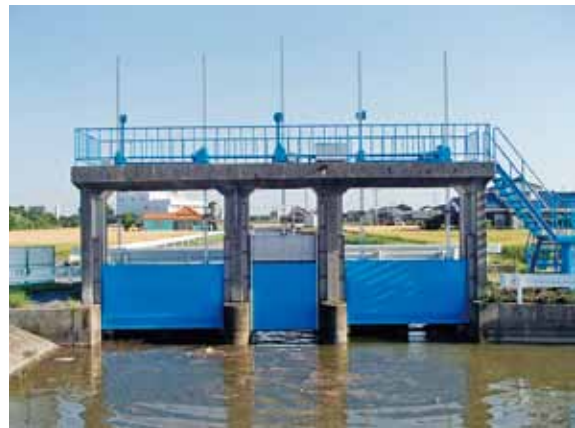
補修後のゲート
