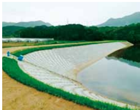
整備されたため池
