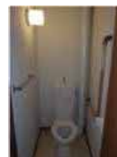
↑ バリアフリーに配慮した便所
