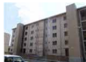
↑ エレベーター設置による共用部分のバリアフリー化
