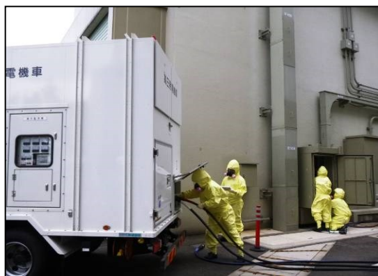
◇高圧発電機車の電源ケーブル接続 (汚染防護具着用)
