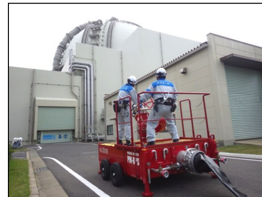
◇放水砲の設置
