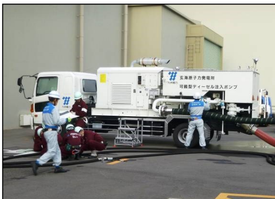
◇可搬型ディーゼル注入ポンプの設置
