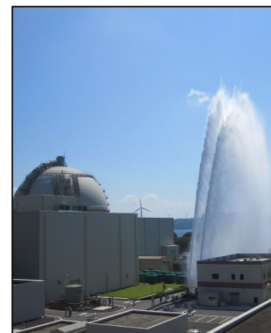
◇放水砲による放水
