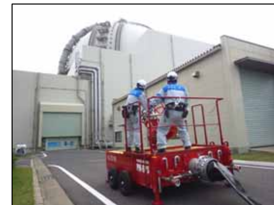
放水砲の設置
