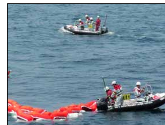
シルトフェンス(海中カーテン)の設置
