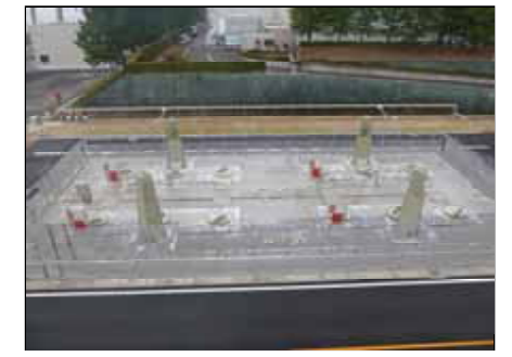
非常用ディーゼル発電機燃料油貯蔵タンク増設
