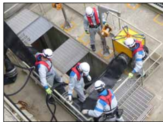
海水を取水するための水中ポンプの設置
