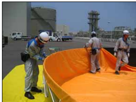
中間受槽(水槽)の設置
