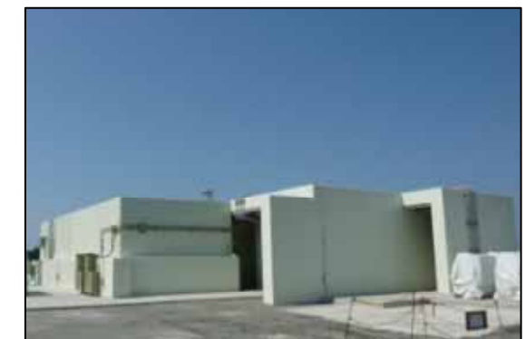
代替緊急時対策所
