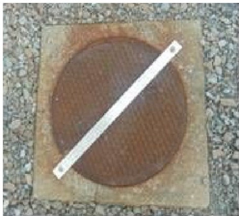
(1)マンホールふた
