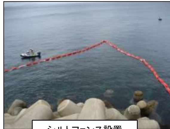
シルトフェンス設置
