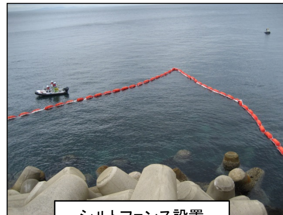
シルトフェンス設置
