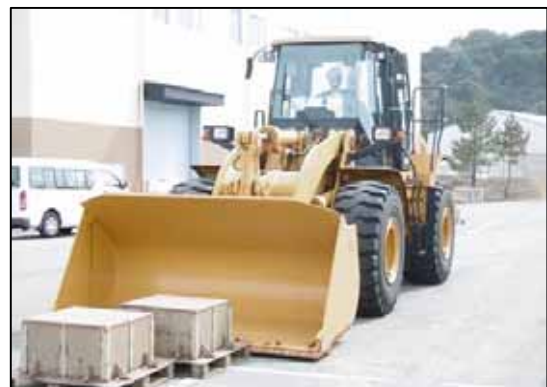
資機材の運搬ができるよう、がれきを撤去する訓練
