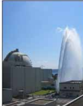
放水砲による放水訓練
