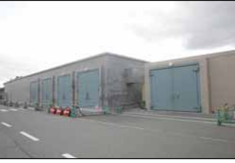
保管庫の設置
