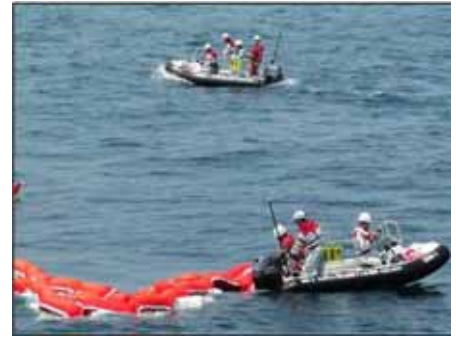
シルトフェンス(水中カーテン)の設置
