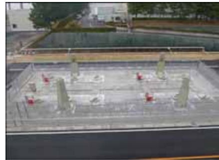
ディーゼル発電機の燃料油貯蔵タンク増設
