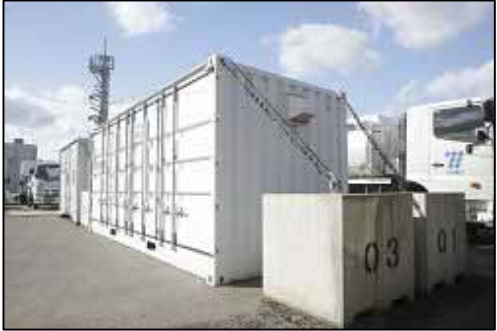
資材保管用コンテナの固縛
