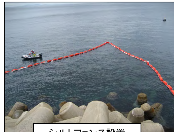
シルトフェンス設置
