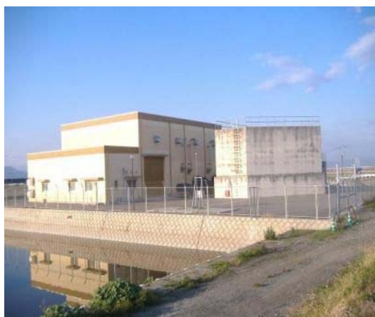
写真 2：地盤沈下による湛水被害を解消するために建設された排水機場（白石平野地区）
