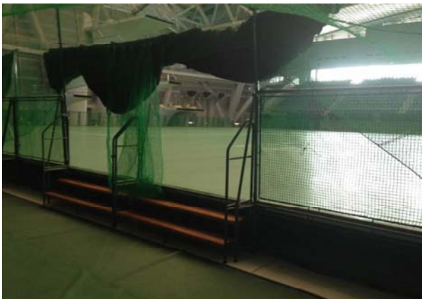
端部防球ネット設置
