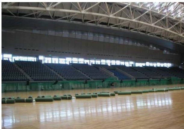
仮設鋼製床設置後
