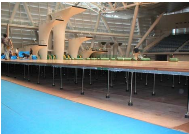
仮設鋼製床端部
