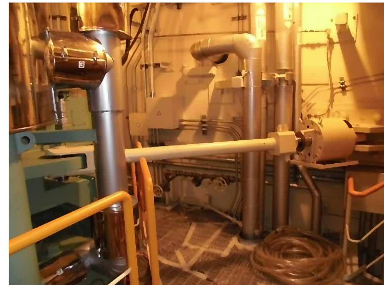
1次冷却材ポンプ支持構造物点検
