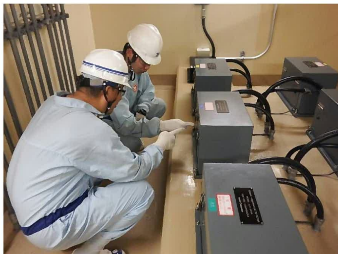
原子炉停止用地震計点検
