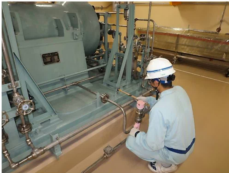
ポンプの基礎ボルト点検
