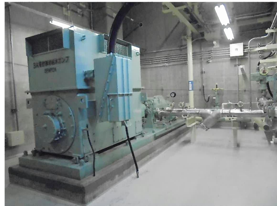
電動補助給水ポンプ作動試験
