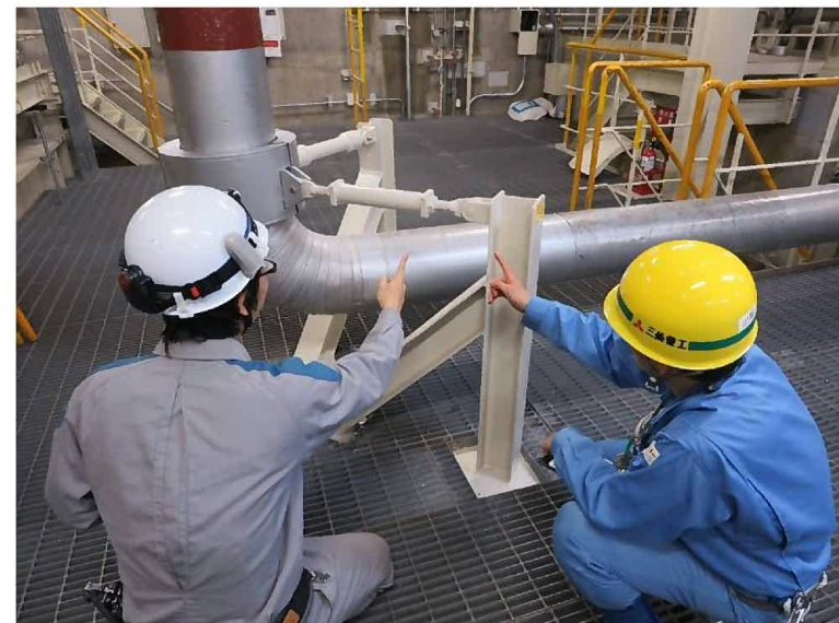
配管の支持装置点検
