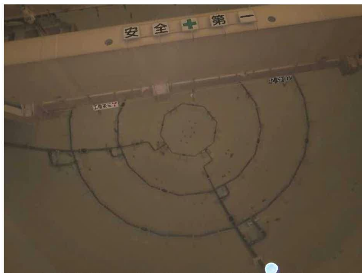
格納容器スプレイ配管点検
