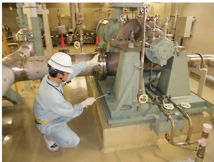
基礎ボルト点検
