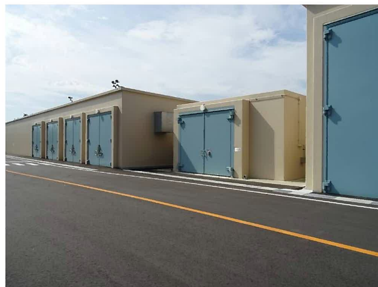
重大事故等対処設備保管庫点検
