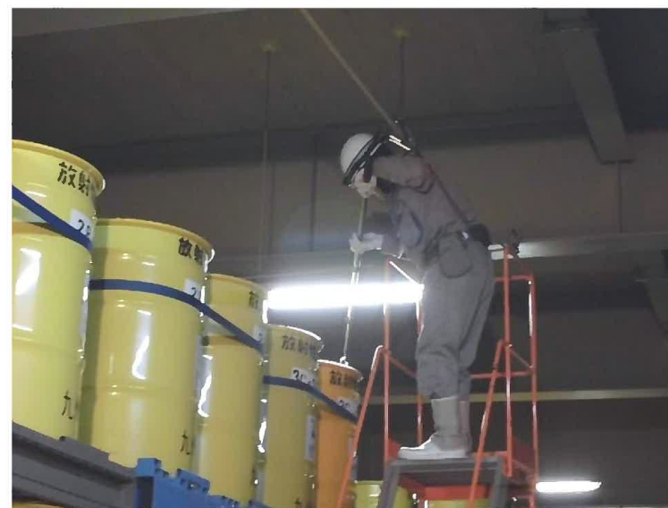
低レベル放射性廃棄物保管容器(ドラム缶)の固縛状態点検
