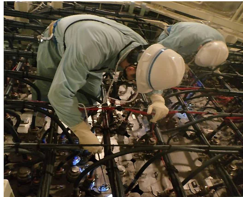
制御棒駆動装置、制御棒位置指示装置ケーブルコネクタ部点検
