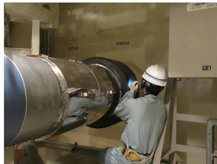
格納容器貫通部点検
