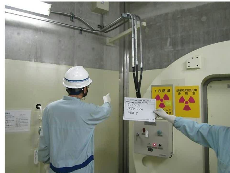
コンクリート構造物点検
