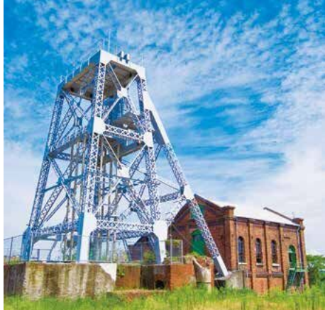
万田坑 堅坑関係施設が良好な状態で保存されている 【所在地】熊本県荒尾市原万田200-2 【連絡先】0968-63-1274 (荒尾市文化企画課)
