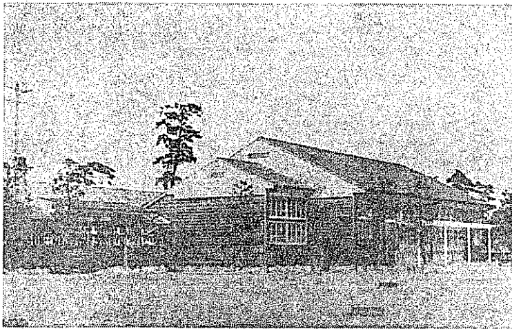
モデル建築候補校として文部省から指定された県立盲学校(昭和27年完工)
