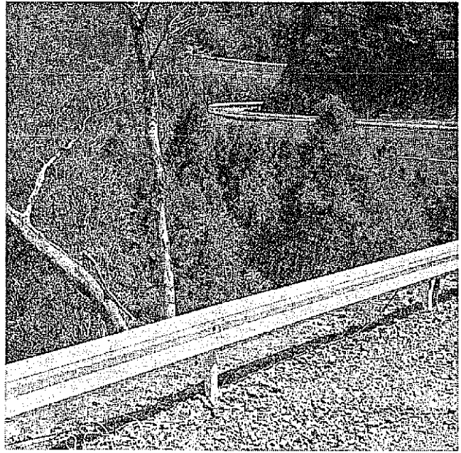
広域基幹林道(嬭野町)
