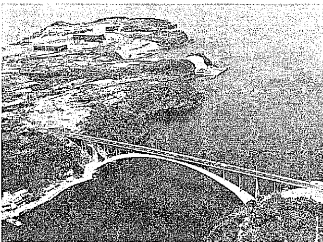
外津大橋（鎮西町～玄海町）昭和49年5月完成
