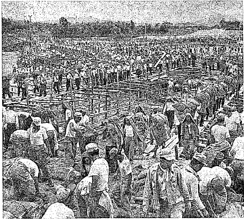
決壊堤防の仮締切り(嘉瀬川)
