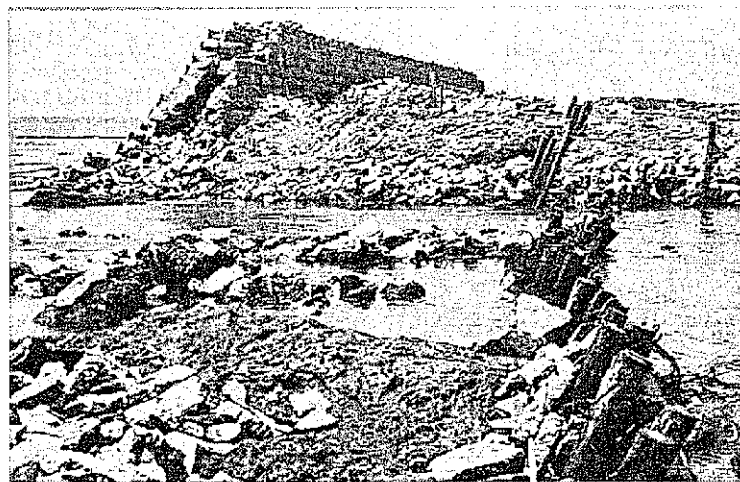
過去10年間営々として築いてきた干拓堤防の決壊(西川副干拓)
