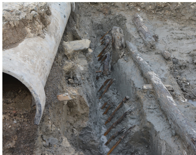
写真4 柵（しがらみ）・丸太杭検出状況 （調査区南から）
