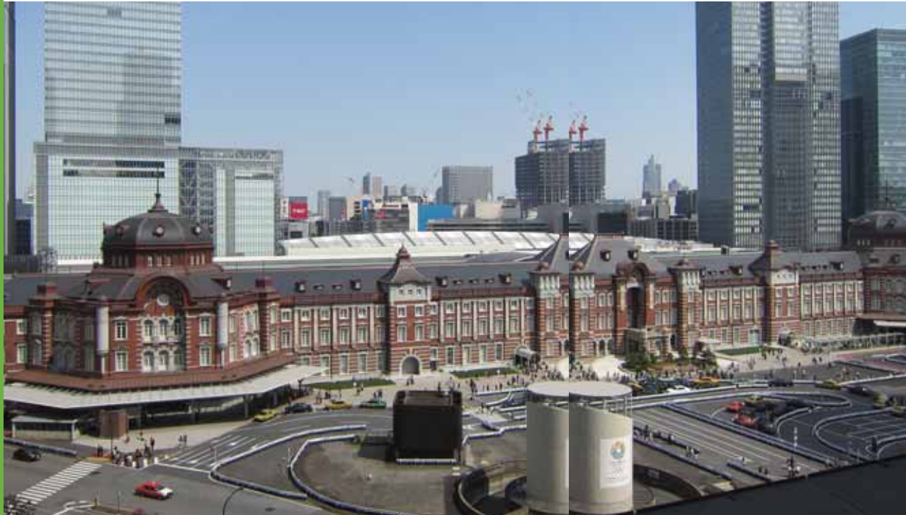
東京駅 [東京都千代田区] 辰野金吾/1914年(大正3)年/国重要文化財 「辰野式」建築の代表作。東京大空襲で建物は大きく損壊しましたが、2012(平成24)年に
