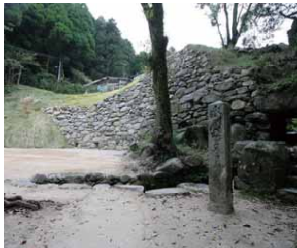
基肄城水門跡 水口の規模は国内最大級です。
