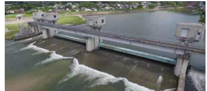
川上頭首工 (佐賀市大和町)
