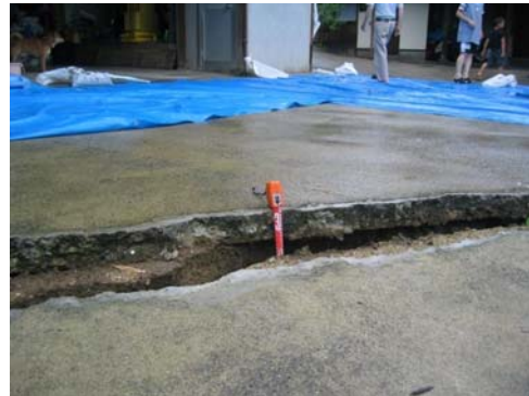
宅地土間コンクリートの亀裂
