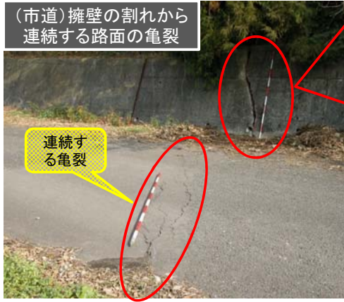
(市道)ブロック積み擁壁の割れ
