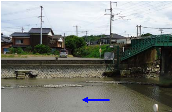
0k475付近(JR橋下流左岸状況)
