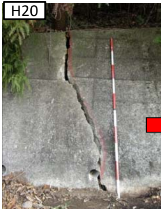
市道擁壁の割れの拡大
