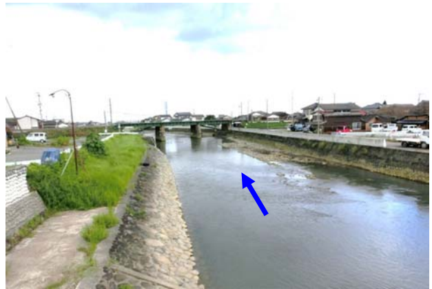
0k550付近(浜大橋より下流を望む)
