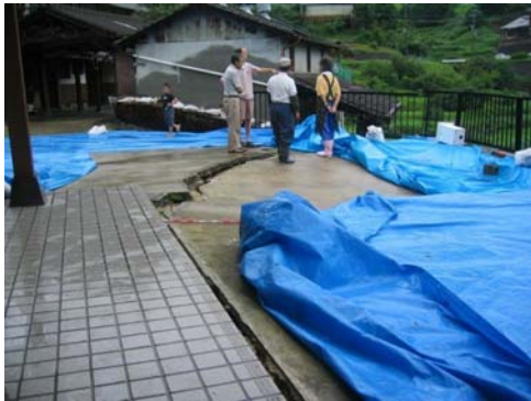
宅地土間コンクリートの亀裂
