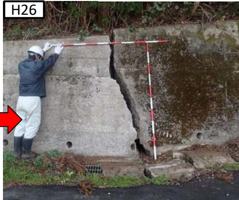
市道擁壁の割れの拡大
