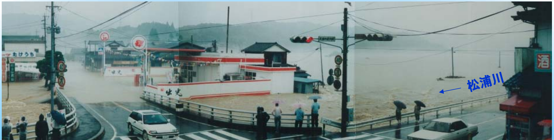
梅の原橋付近の浸水状況
