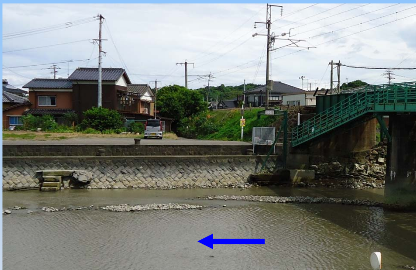
0k475付近(JR橋下流左岸状況)
