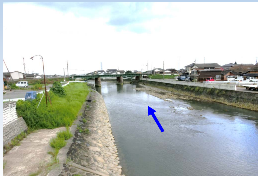
0k550付近(浜大橋より下流を望む)
