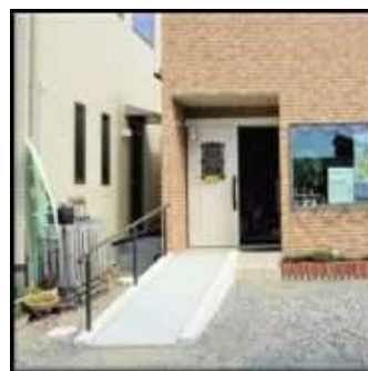
スロープや手すりが設置された入口
