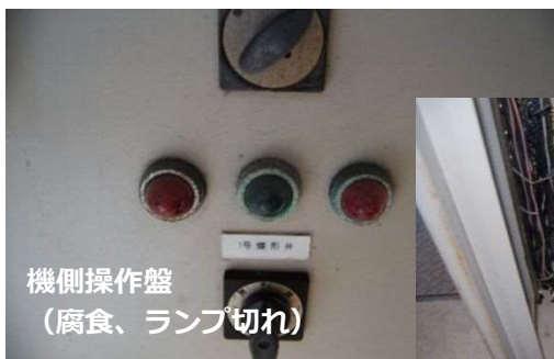
継電器盤／屋内設置 （盤内部：発錆）
