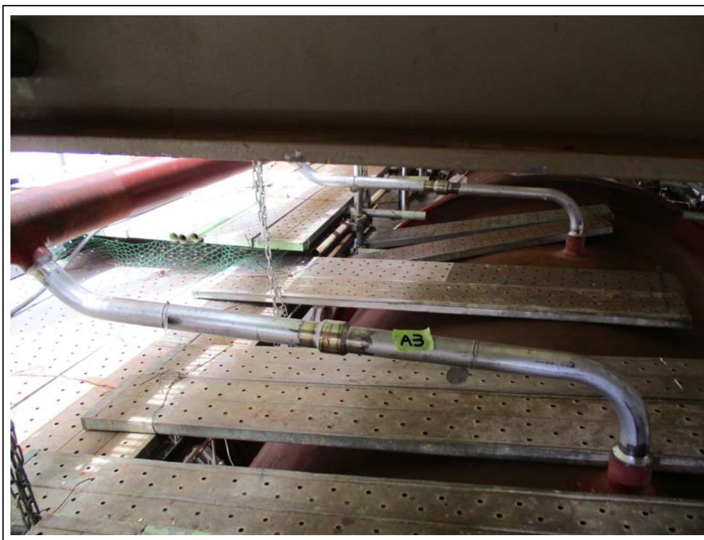
取替後（ステンレス鋼 / 溶接部塗装前）
