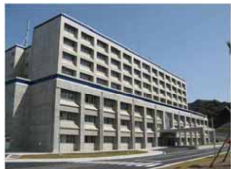
隊庁舎（高知駐屯地）
