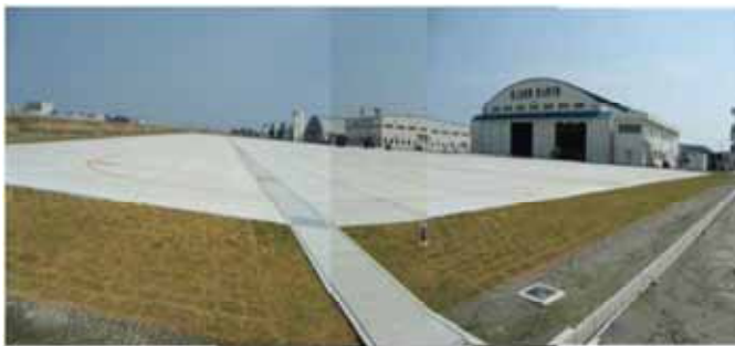
駐機場・格納庫（北徳島駐屯地）
